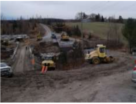
9. Remblais des culées et de l'empierrement axe 1
