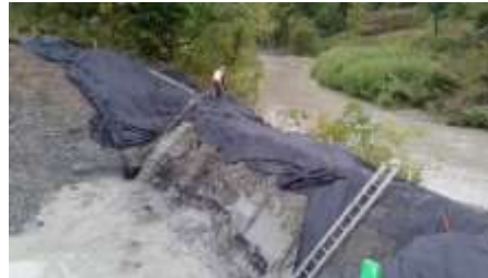
2. Excavation pour recevoir les pieux!
