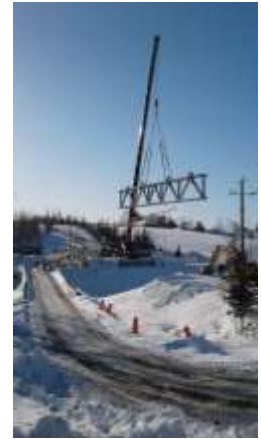
12. Levée des structures - 7 février 2023
