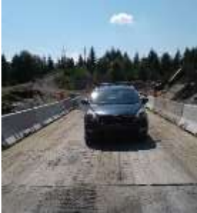
1. Nous passons sur le pont temporaire et le chemin de contournement.
