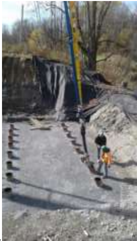
4. Le béton est mis dans les pieux
