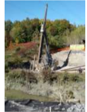
3. Fonçage des pieux, il y en a 16 par côté de rive.
