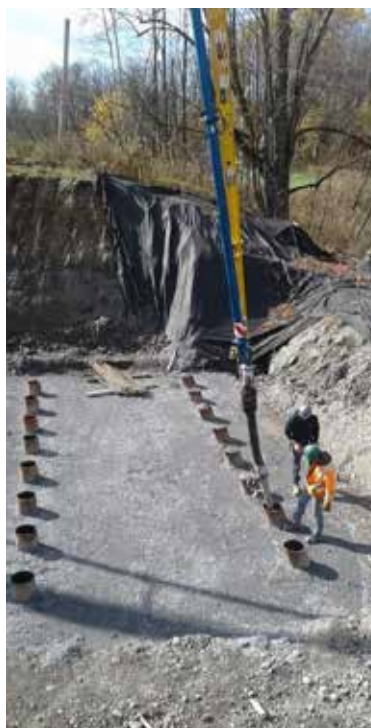
4. Le béton est mis dans les pieux.
