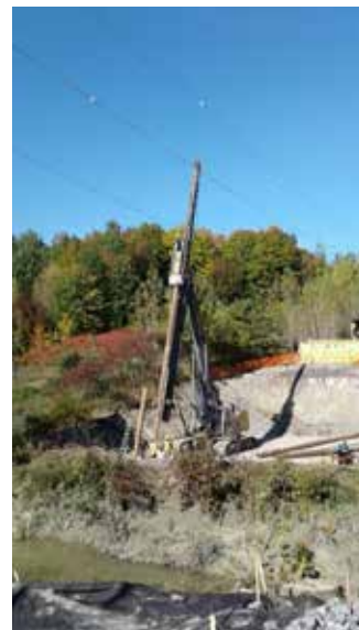
3. Fonçage des pieux, il y en a 16 de chaque côté de la rivière.
