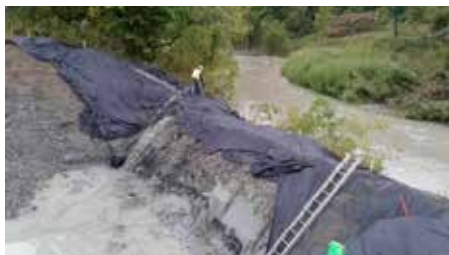
2. Excavation pour recevoir les pieux, impressionnant!
